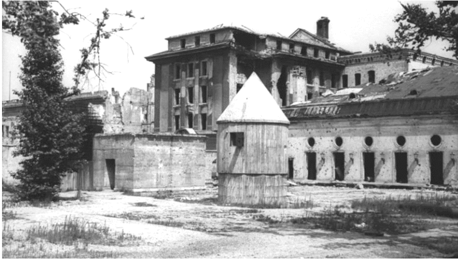
Entrada do Führerbunker nos jardins da Chancelaria, com a torre de ventilação
